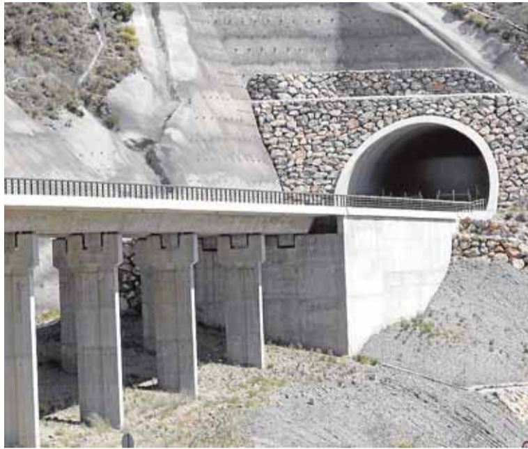
Los túneles de Sorbas, en Almería, fueron tapiados en 2014. ■ EFE
