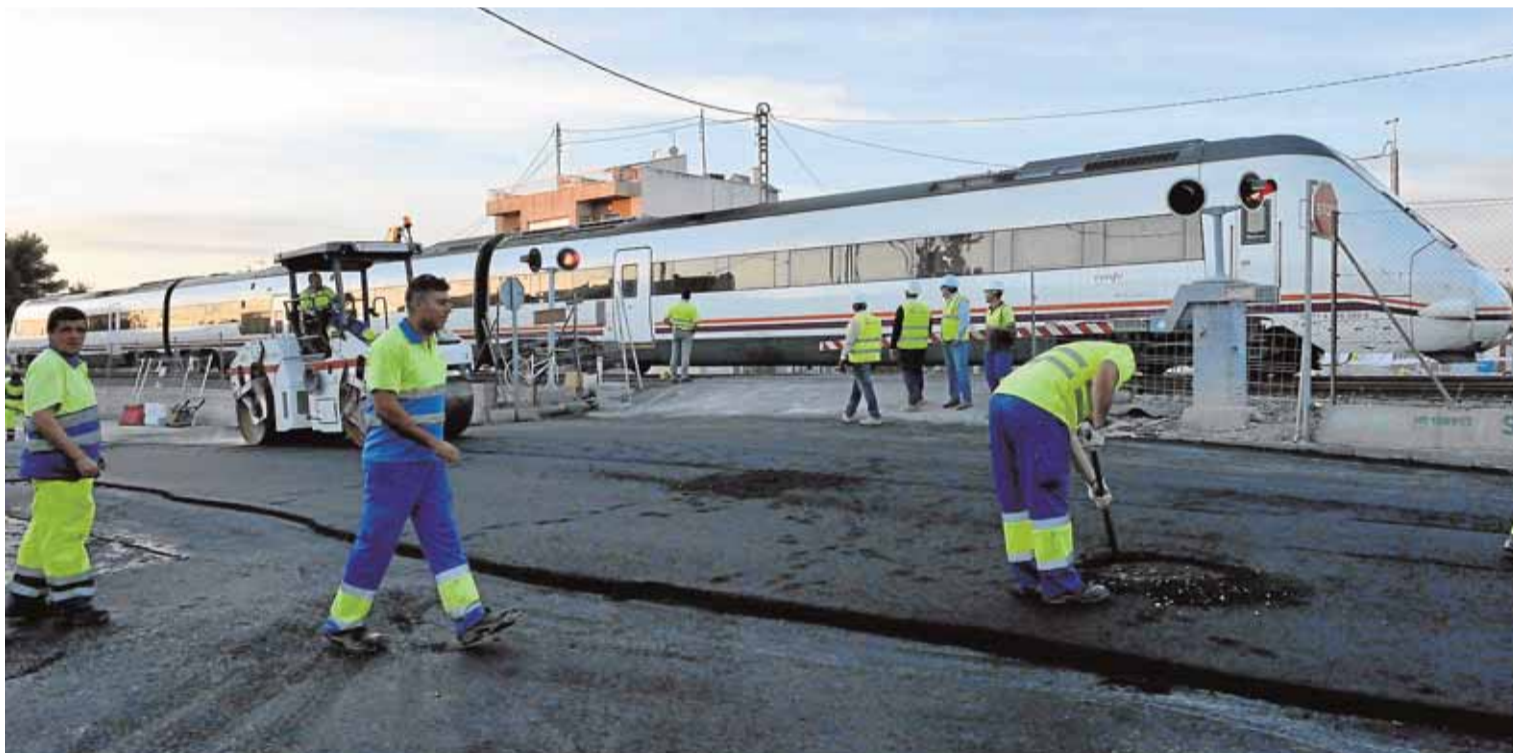
Operarios trabajando ayer en la renovación del pavimento en el paso a nivel de Senda de los Garres. :: GUILLERMO CARRIÓN / AGM
