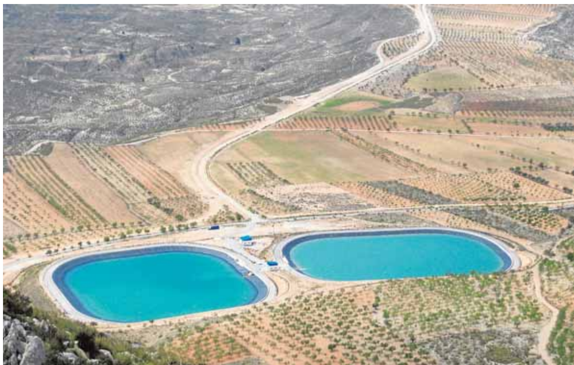
Dos balsas de regulación del trasvase Negratín-Almanzora. :: AGUAS DEL ALMANZORA
